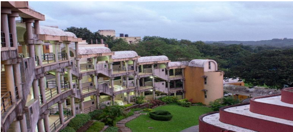
Das terrassenförmig angelegte Universitätsgebäude
